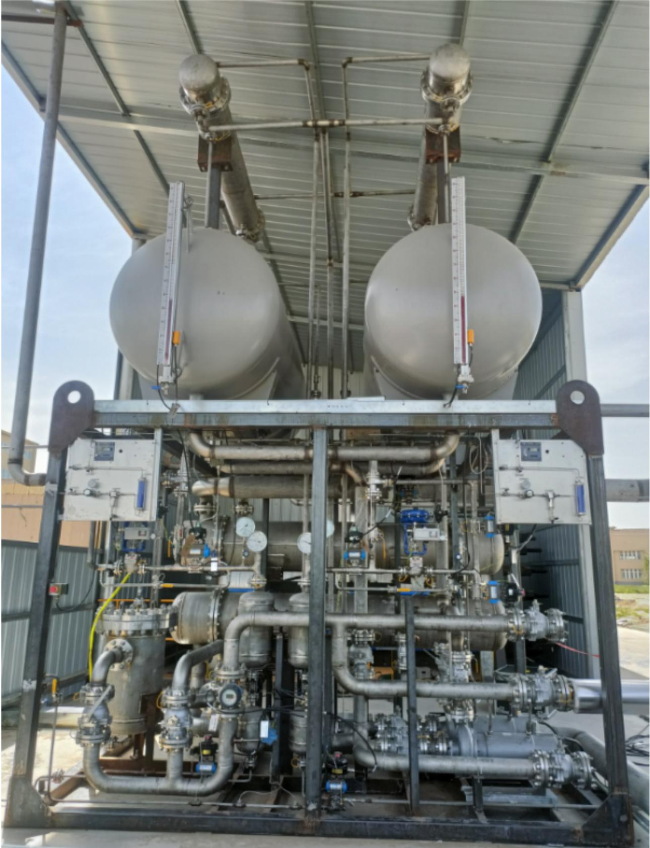
氢田时代测试中心位于鄂尔多斯市亿利库布其工业园区内，占地600平方米，包括可移动式电解槽安装区、1000-2000Nm<sup>3</sup>/h制氢后处理（BOP）系统、变压室、整流室、制氢自动化控制室和补水配碱室，测试中心使用园区发电厂输送的35KV高压电，经变压和整流给电解槽提供持续的电力需求，同时，测试中心循环冷却水和纯水全部由亿利园区水务系统全方位供应，保障了测试中心长期稳定运行。
