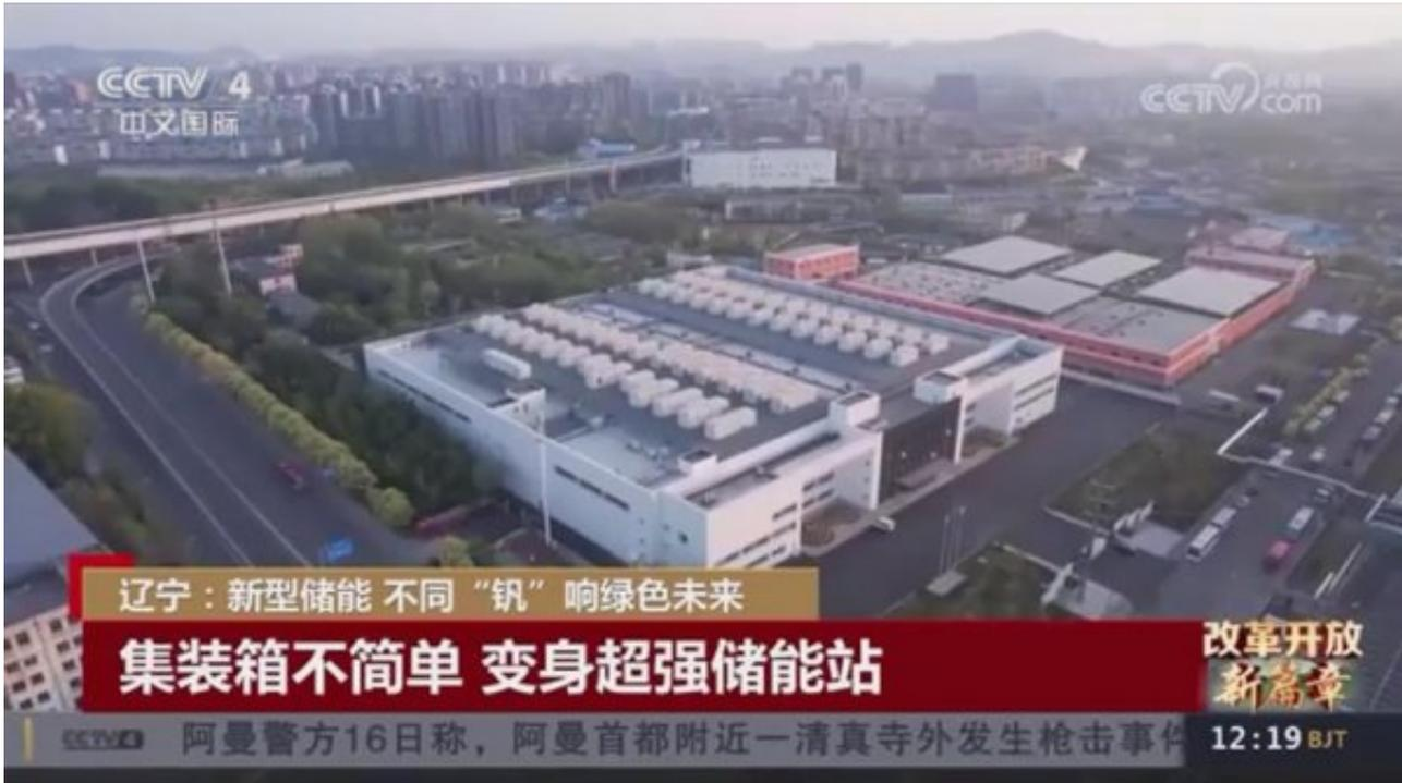
通过航拍画面，在距离我们这座工厂50多公里外的大连主城区内，有整齐排列的700多个钒液罐和一个个更大的电堆集装箱，就组成了全球首座100兆瓦级液流电池储能电站，它也是我国首个国家级的大型化学储能示范项目。在智能控制中心的调控下，满负荷可以储存40万度电。储能，顾名思义就是把能量给储存起来，需要用的时候再释放出来。
