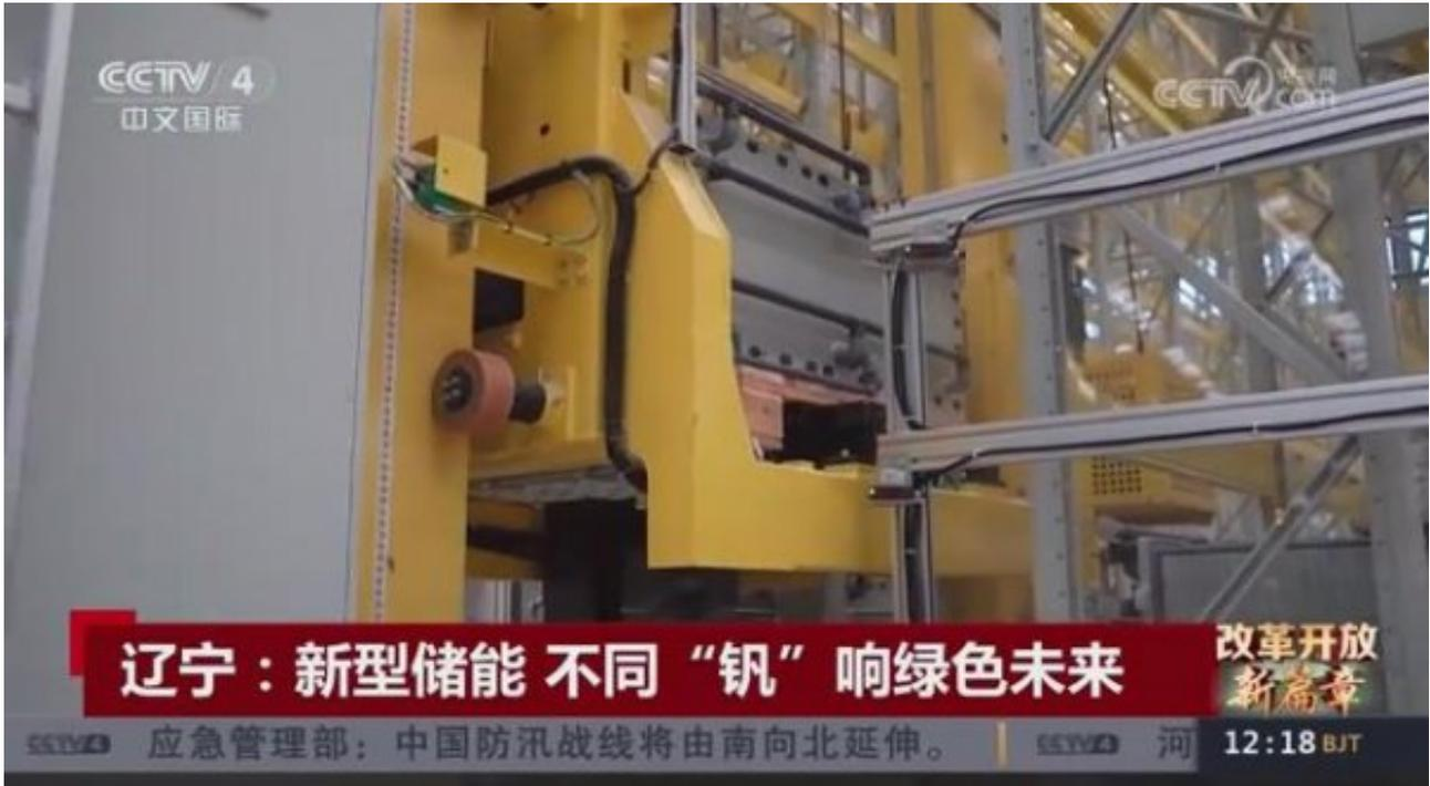
答案是其实也不是，它只是全钒液流电池的一半，而另一半则是我前方的这些。既然叫全钒液流电池，听名字就要有液体，看，这些钒电解液，是电池的关键材料，它占了总成本的一半。一个装有电堆的集装箱和一个装有钒电解液的集装箱，两者一组合就构成了一套完整的钒电池储能系统。
