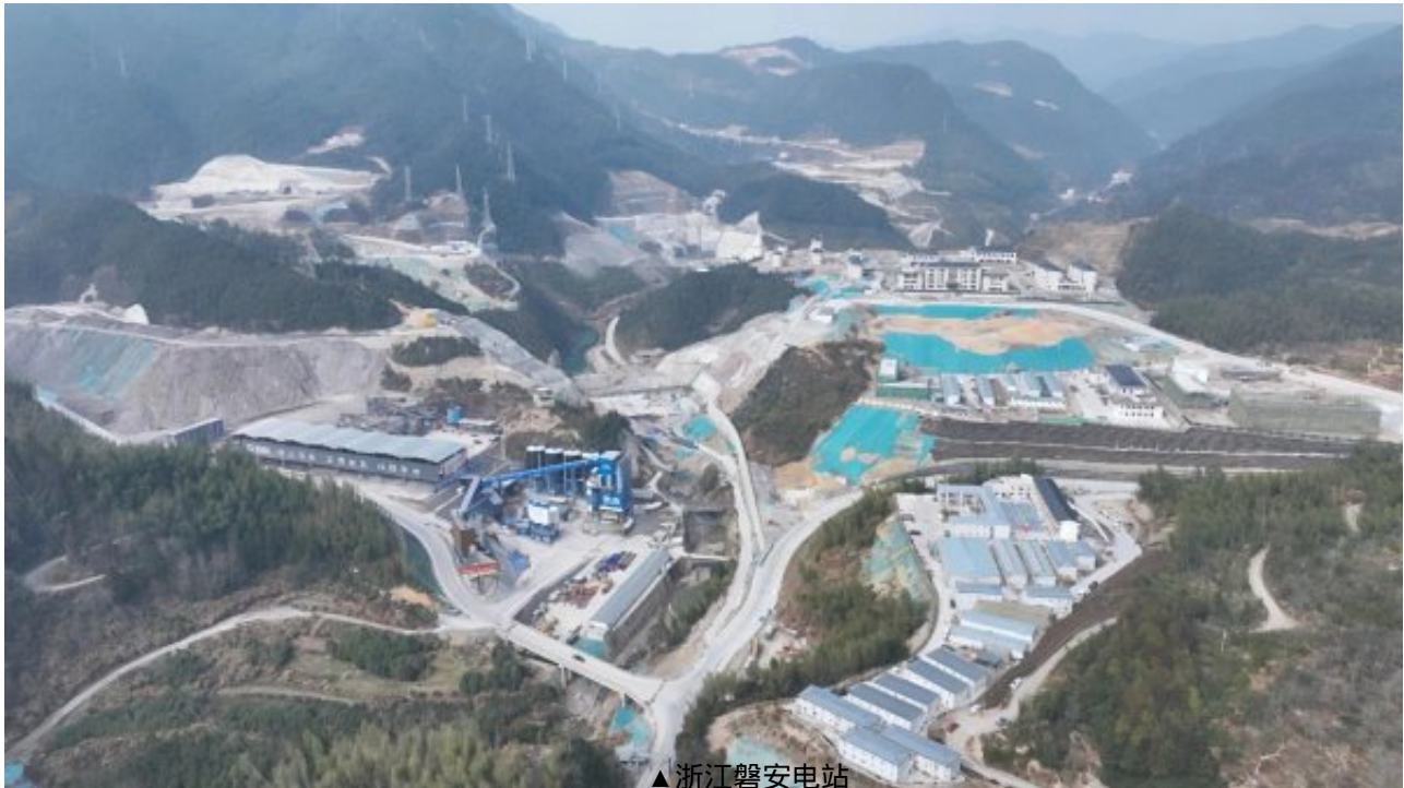
▲浙江磐安电站
