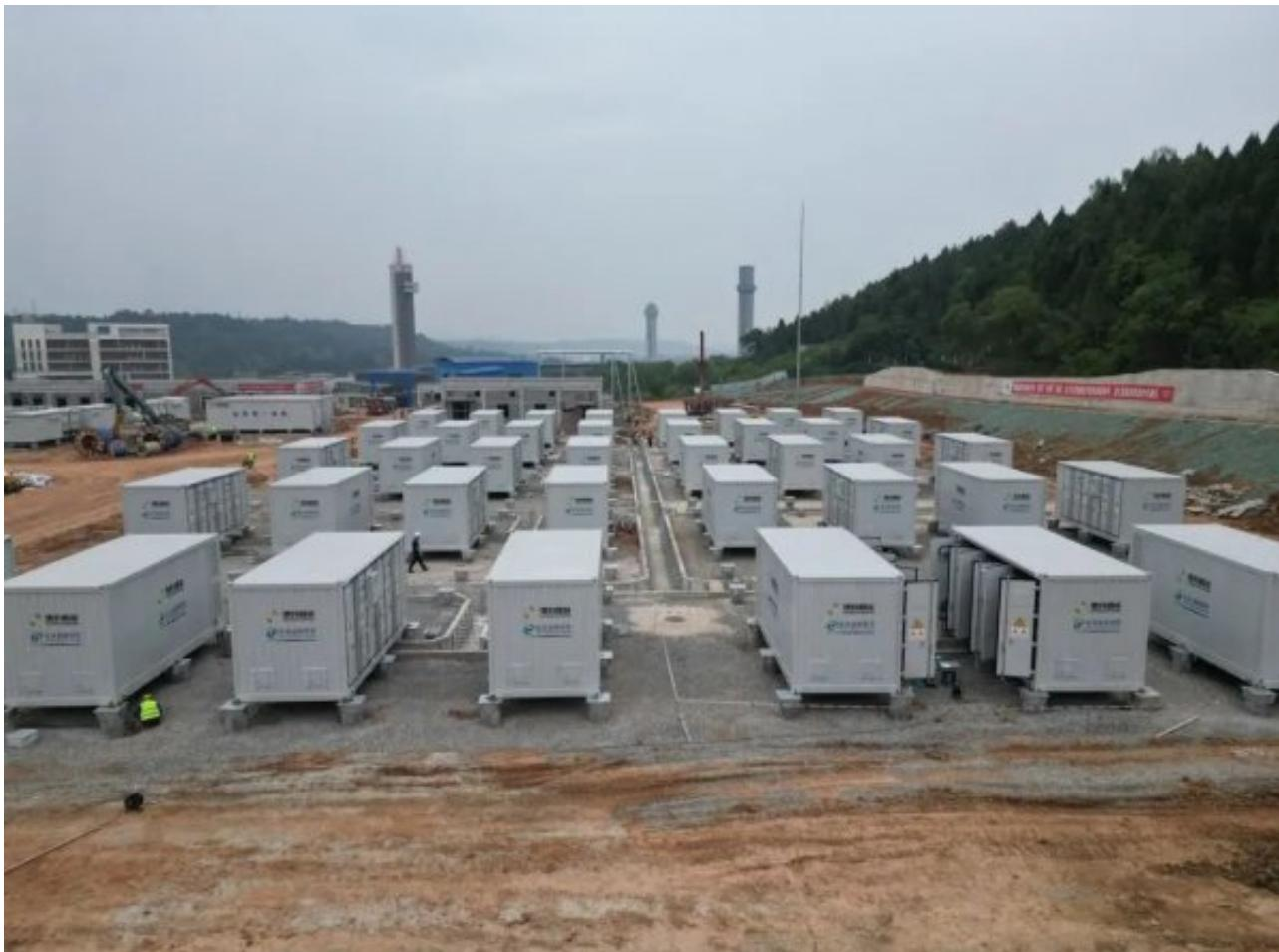
绵阳港旗储能电站（一期）是四川省示范重点项目，由绵阳港旗储能技术有限公司投资建设。项目选址于游仙区石马镇百胜村，总用地面积约75亩。其规划建设涵盖100MW/200MWh电化学储能以及15MW飞轮储能，并配套建设1座110kV升压站。自项目启动以来，各参建单位始终将“确保质量、控制安全”作为核心目标，齐心协力、攻坚克难，构建起“责任分明、考核清晰、奖罚分明”的闭环管理机制，为项目的高质量建设提供了坚实保障。
