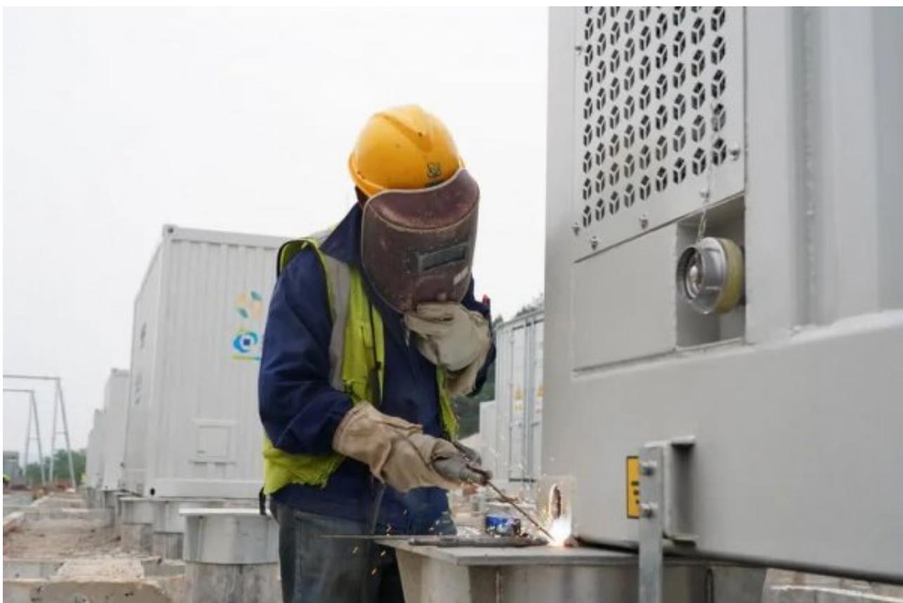
“我们这个储能仓容量为五千度电，里面配备了48个电池包，每个电池包内有104块电芯，一个电池包的存电量达104度。一个六口之家的家庭一个月的用电量大概是100度电，这意味着一个电池仓就能满足50个家庭一个月的用电量需求。”绵阳港旗储能技术有限公司交付经理颜博向记者介绍。
