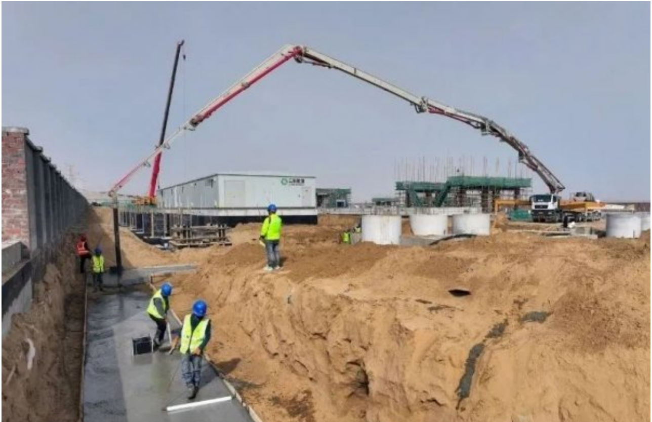
6月12日，和田县境内的立新和田县300兆瓦/1200兆瓦时独立储能项目施工现场，工人们正在进行浇筑作业。甄立民 摄
