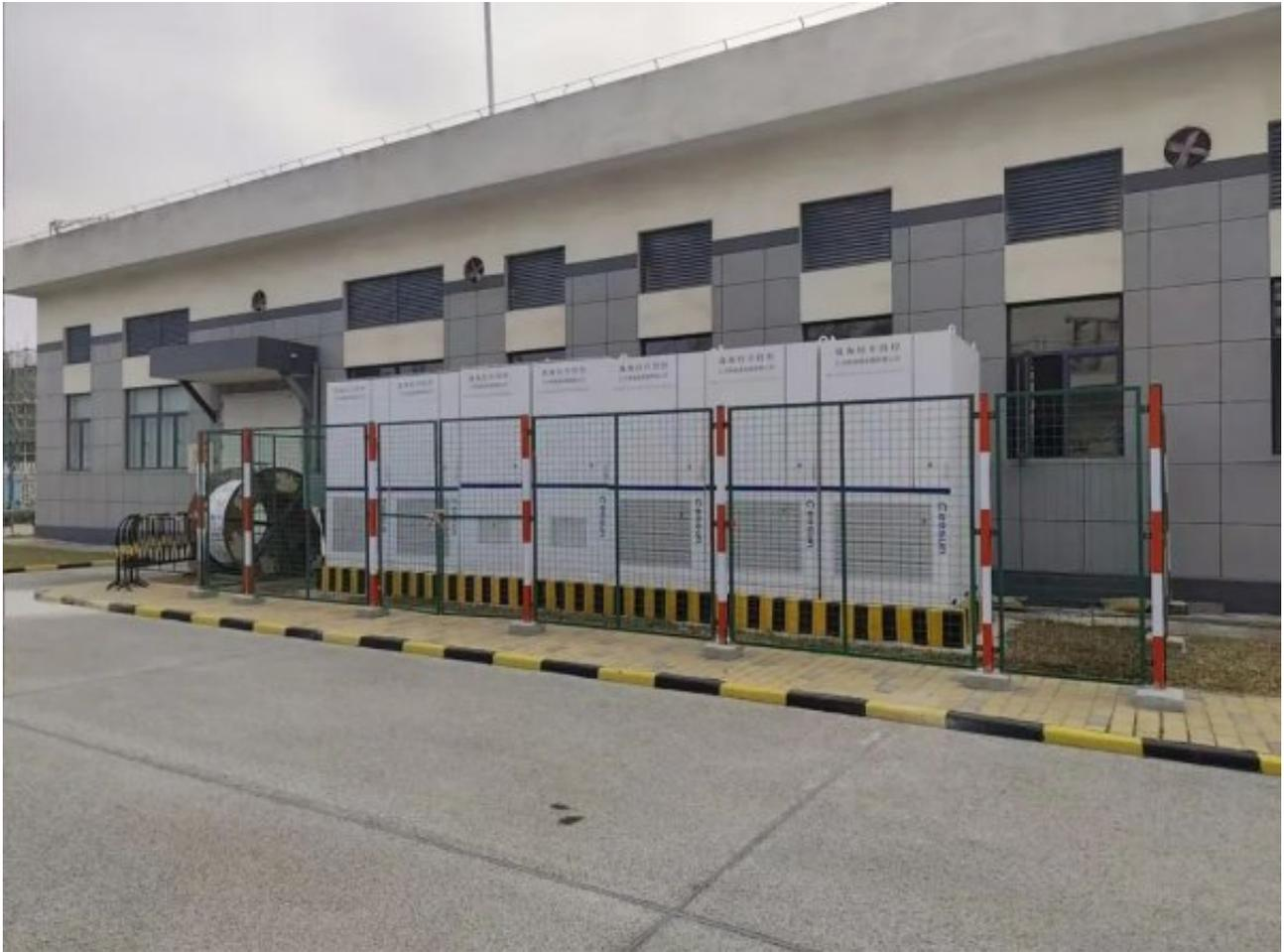
该项目由经开投控下属汇华新能源公司投资建设，本项目的投用是经开投控积极践行绿色低碳发展的重要实践。据悉，该项目将有效发挥“削峰填谷”作用，在用电低谷时段储存电能，于高峰时段释放使用，不仅能有效降低生产运行电费成本，提升能源利用效率和经济性，更能减轻区域电网高峰时段的供电压力，为城市电网平稳运行提供有力支持。
